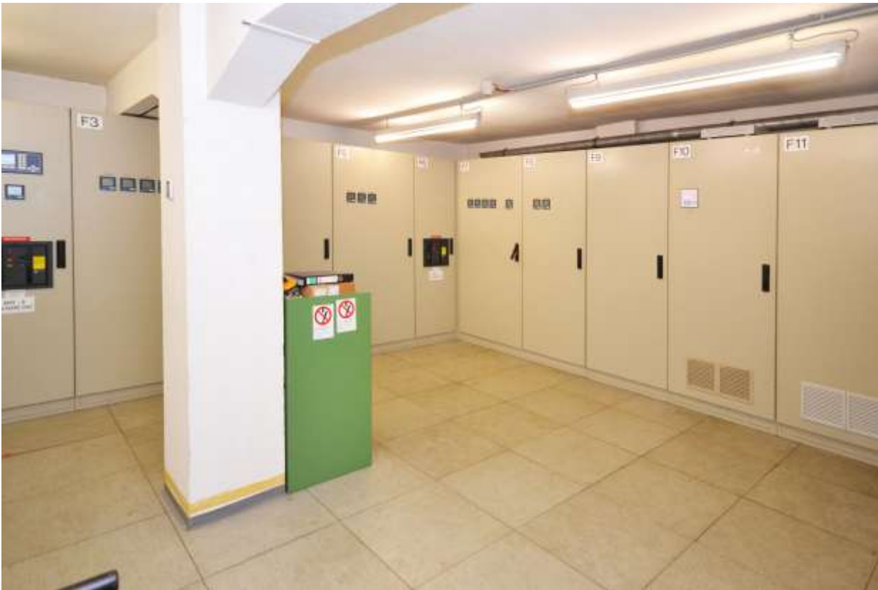
Rozdzielnia niskiego napięcia – piwnica 2 budynek wysoki 2.1
