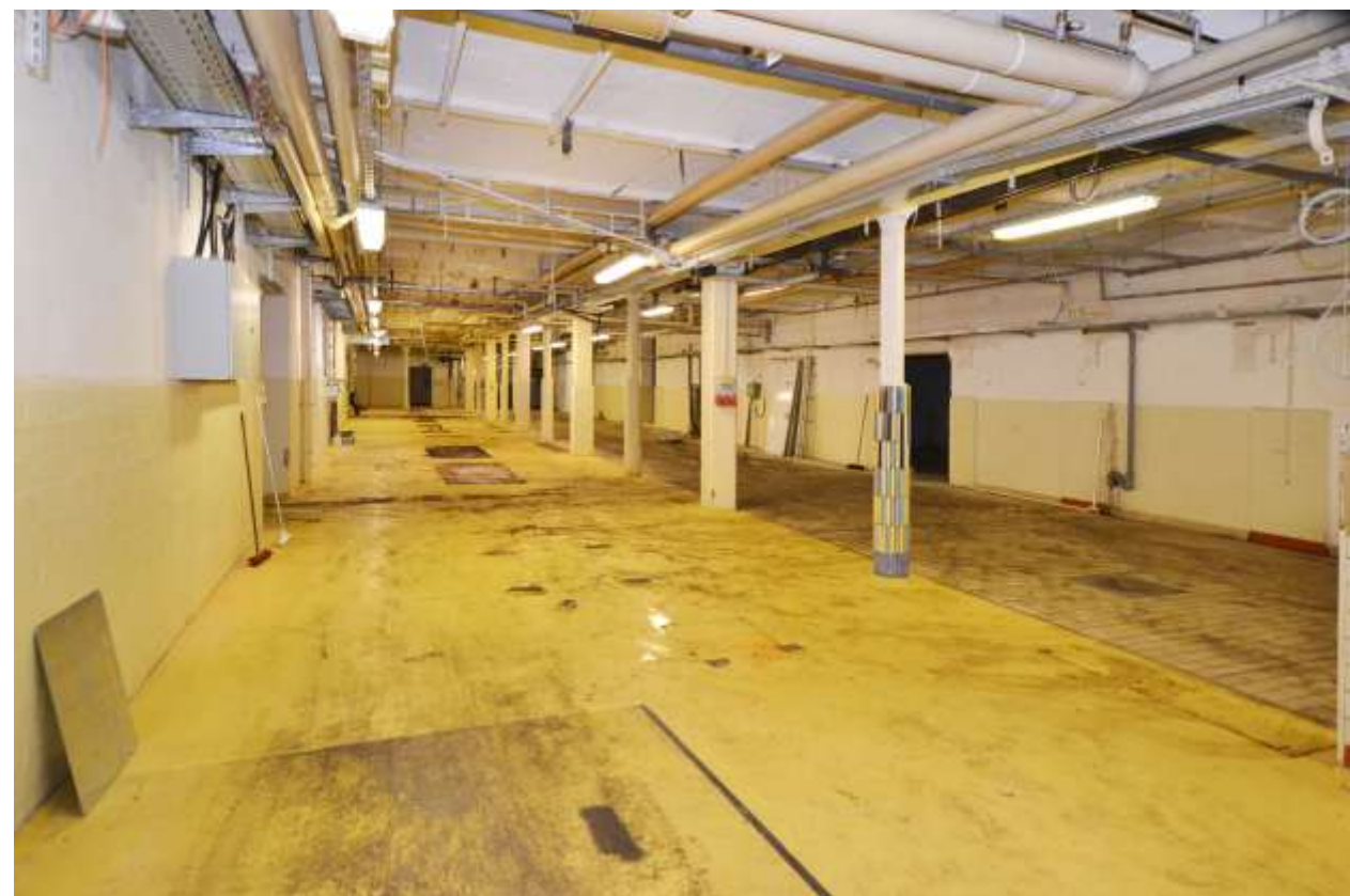
Budynek środkowy 2 – parter
