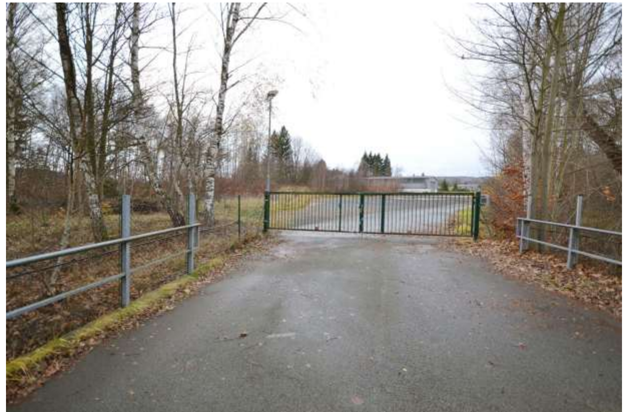
Droga do hali magazynowej 4
