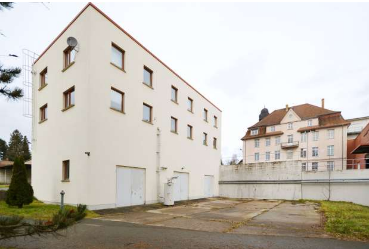
Budynek warsztatowy 6 Budynek administracyjny 1
