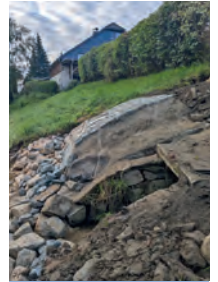
Schachtauslauf Untere Dorfstraße
