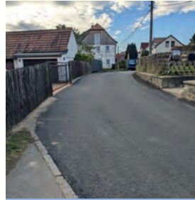
Asphalt Untere Dorfstraße Breitbandabschnitt
