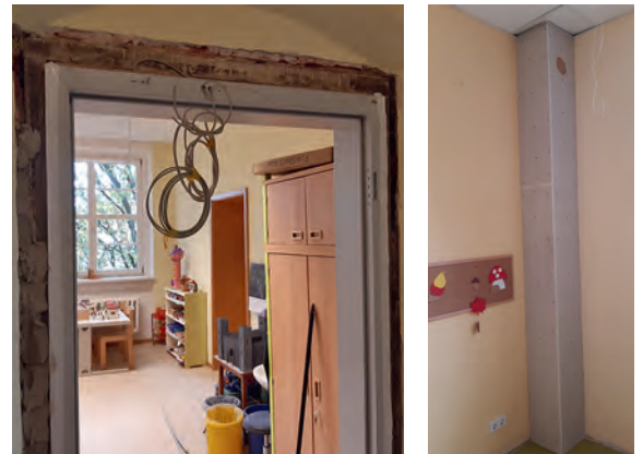
Brandschutztechnische Bauten im Hort
