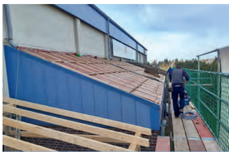
Erneuerung Dach Geräteräume Turnhalle NO
