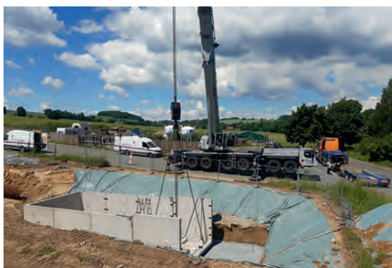
Errichtung Löschwasserbehälter Gewerbegebiet
