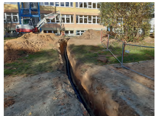
Errichtung Nahwärmetrasse Grundschule/Hort
