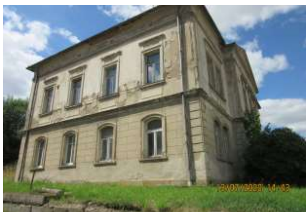
Giebelansicht mit Putzschäden, 2020
