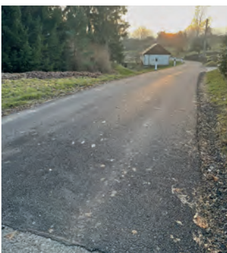
Straßenbau Im Grunde
