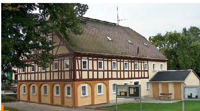
Fassadenrenovierung am gemeindeeigenen Wohnhaus Straße der Republik 56
