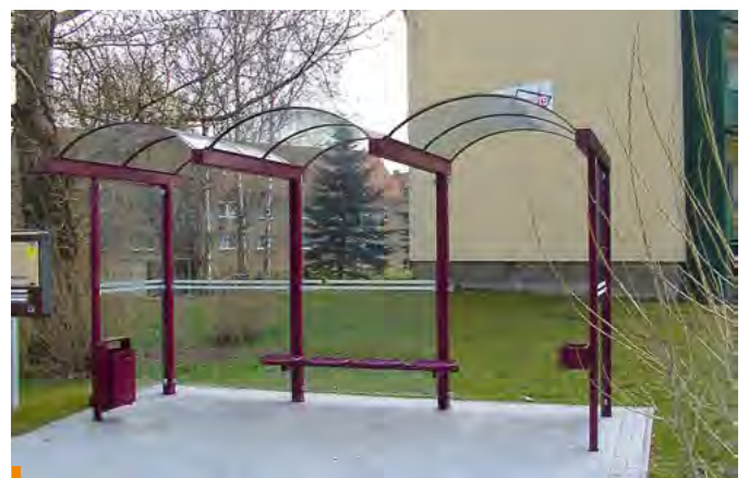
Errichtung von 7 neuen Buswartehallen in der Ortslage
