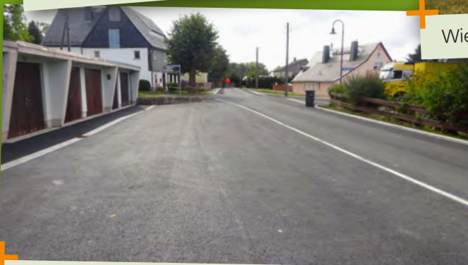
Straßenbau Hintere Dorfstraße
