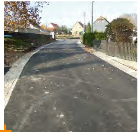
Ausbau eines weiteren Abschnitts auf der »Dorfstraße«
