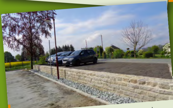
Errichtung Parkplätze Kita »Märchenland«
