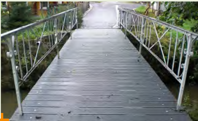
Fußgängerbrückensanierung über das Landwasser mit Recyclingbelag
