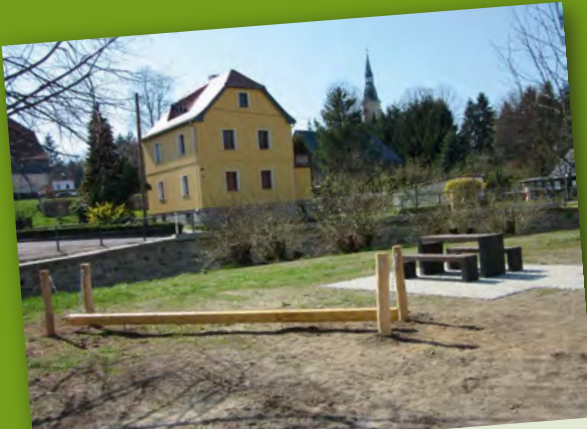
Errichtung von Balancierbalken auf der Dorfstraße mit Sitzgruppe sowie auf dem Spielplatz Kirchstraße
