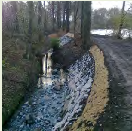
Instandsetzung des Durchlasses an der »Unteren Dorfstraße« sowie Arbeiten am Damm des Spitzkunnersdorfer Wasser
