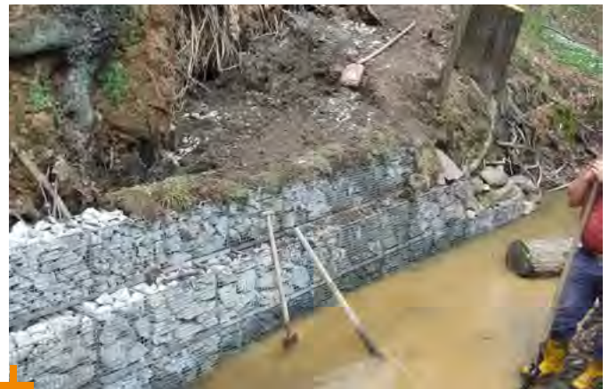
Befestigung des Ufers am Spitzkunnersdorfer Wasser
