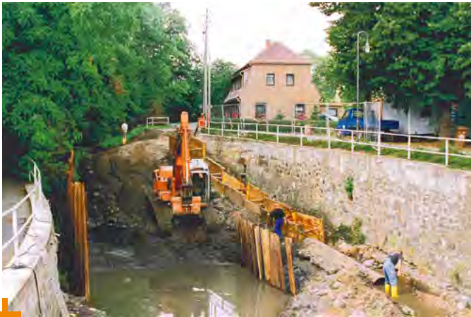
Rekonstruktion des Wehres an der Brennerei
