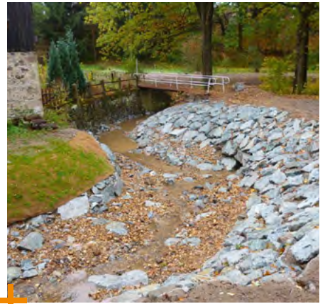
Böschungssicherung am Neufeldenwasser
