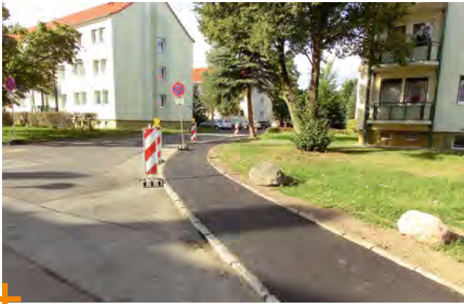
Gehwegbau an der »Otto-Buchwitz-Straße«
