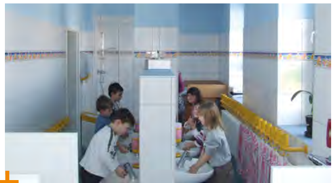
Umbau der Sanitäranlagen in der Kita »Knirpsenland«
