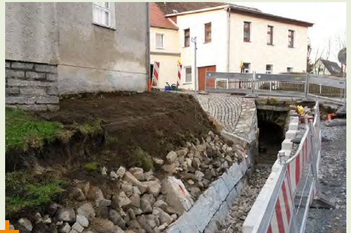
Beräumung des Uferbereiches am Landwasser und Instandsetzung des Grabens am »Uferweg«
