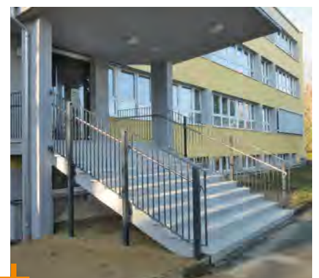
Ein weiterer Teil der Sanierung der Oberschule konnte abgeschlossen werden.
