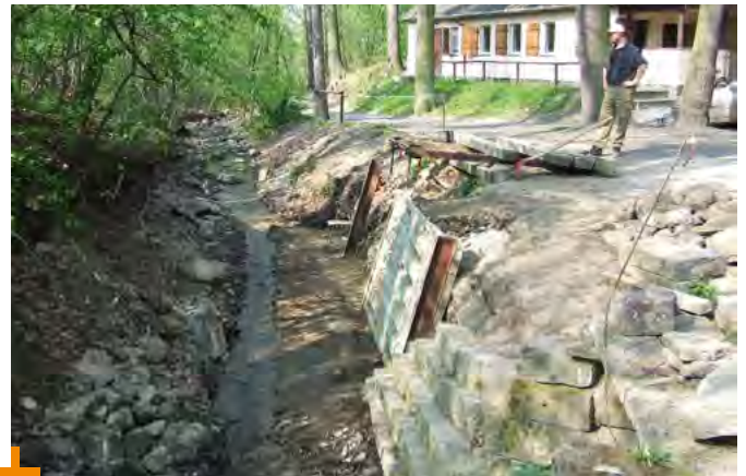
Sicherung Bachmauer Neufeldenwasser am Gründelfestplatz
