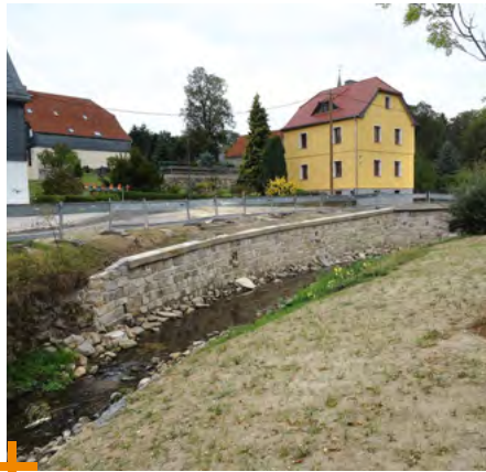
Instandsetzung der Stützmauer am »Kirchweg«
