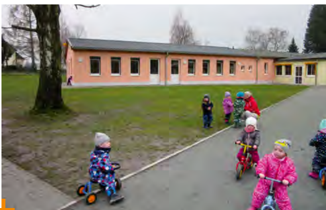
Übergabe des zweiten Anbaus an der Kita »Märchenland«
