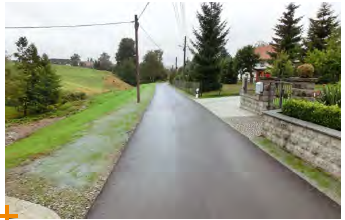
Straßenbau »Im Grunde«
