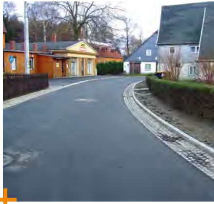
Grundhafter Ausbau mit Errichtung Stütz wand »Kirchstraße«
