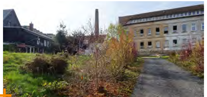
Abriß des Polytechnischen Zentrums vor der Grundschule und der ehemaligen Bücherei auf der Kirchstraße (jeweils vorher und nachher)
