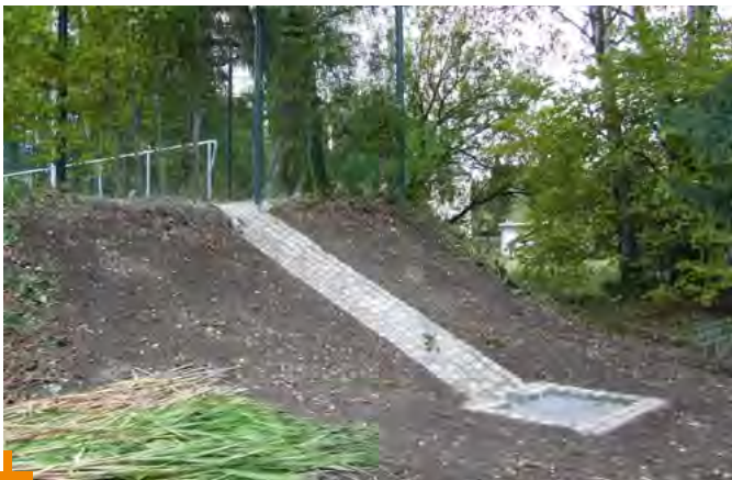
Bau eines Regenwasserablaufs am Sportplatz Oberoderwitz
