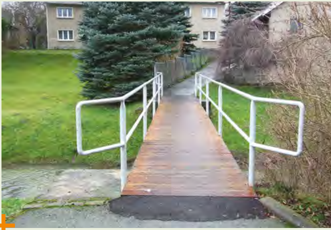
Erneuerung des Brückenbelags auf der Fußgängerbrücke »Postweg« und Stützwandbau am Sportplatz Oberoderwitz
