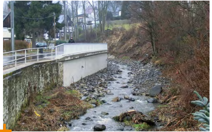
Stützmauerbau an der »Dorfstraße«
