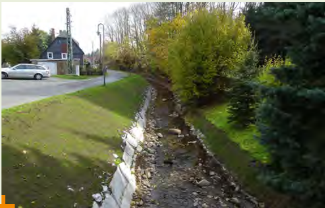
Instandsetzung Böschung bei der »Berthold-Mühle«
