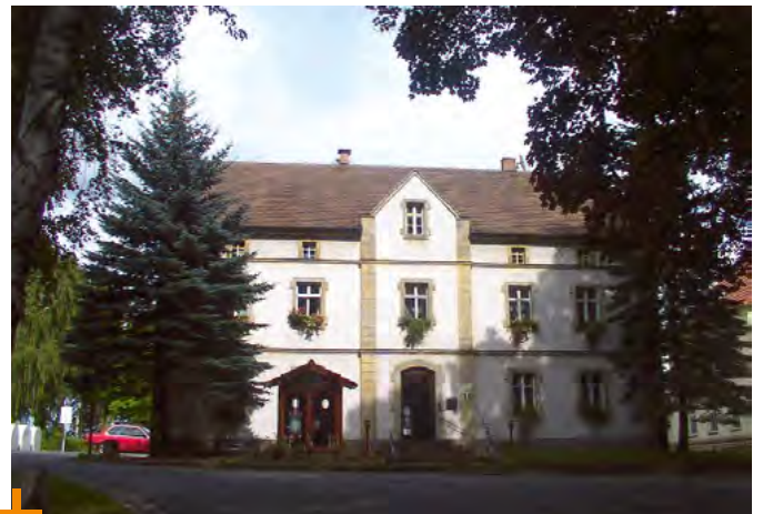
Außensanierung des Wetterkabinetts/ der Touristinformation
