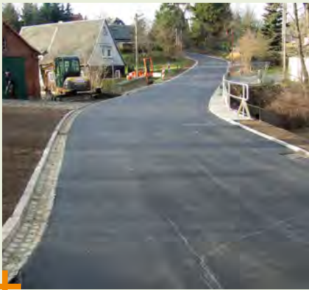
Ausbau des »Adlerberg«
