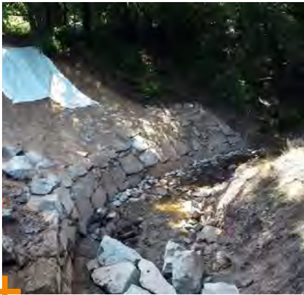
Böschungssicherung am Spitzkunnersdorfer Wasser
