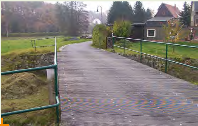
Erneuerung der »Hillerbrücke« und Instandsetzung der Brücke »Dorfstraße«
