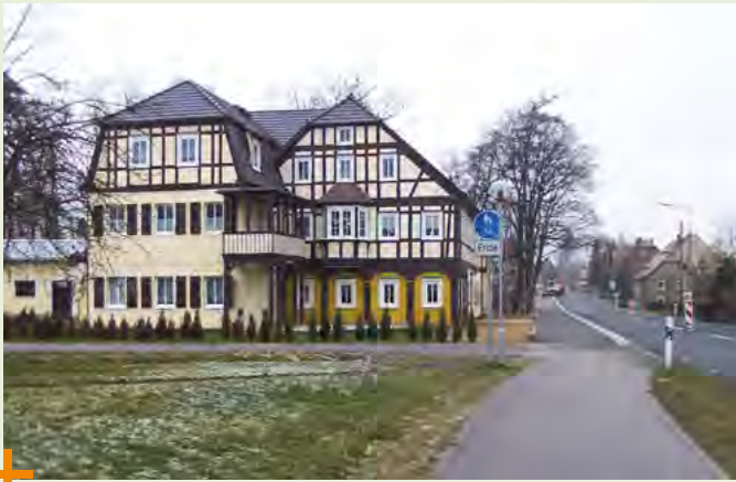
Geh- und Radwegbau an der B96
