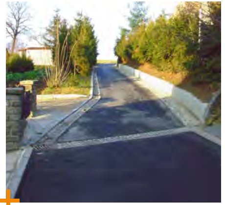
Ausbau der Straße »Querweg«
