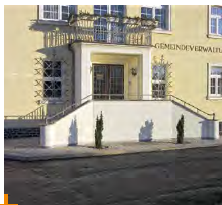
Instandsetzung Treppenaufgang am Gemeindeamt
