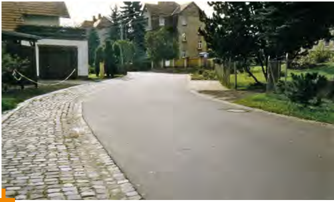
Strassenbau an der »Dorfstraße«
