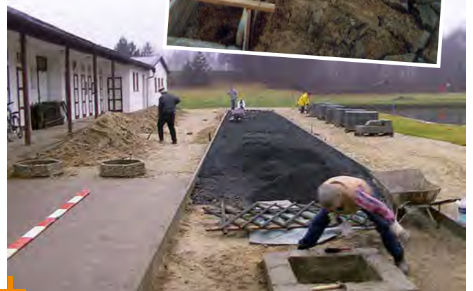
Renovierungsarbeiten am Volksbad mit Instandsetzung der Beckenränder und der Errichtung des neuen Sprungturmes
