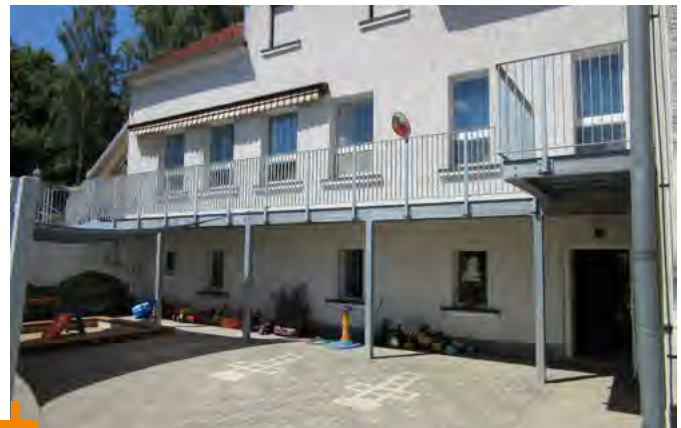
Errichtung eines zweiten Rettungsweges an der Kita »Knirpsenland«
