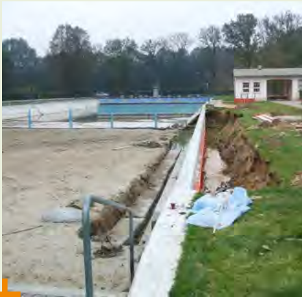
Bau neuer Beckenmauern im Volksbad
