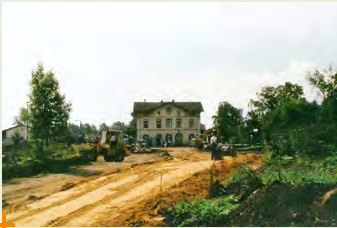
Bauarbeiten und Fertigstellung am Bahnhofsvorplatz
