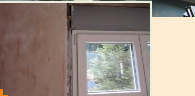
Energetische Sanierung des Gemeindeamtes Haus II
