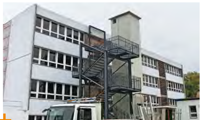
Pestalozzi-Mittelschule während des Umbaus
