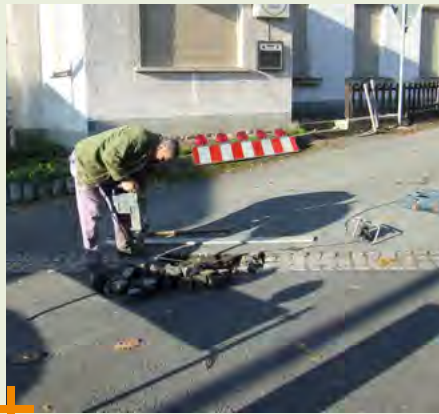
Bauhofarbeiten an der Zufahrt zur Franz-Mehring-Straße
