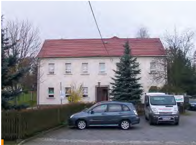
Dachsanierung an der Kita »Knirpsenland«
