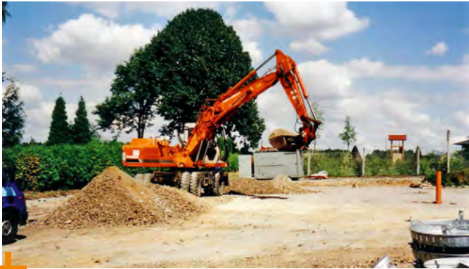
Bau des Buswendeplatzes an der Pestalozzi-Mittelschule
