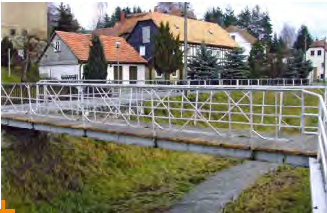
Belag auf der Fußgängerbrücke »Altmanngasse« erneuert
