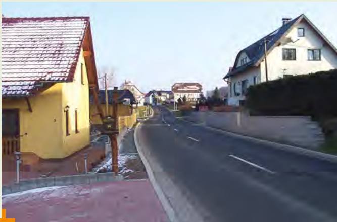
Ausbau S128 mit Rad- und Gehweg
