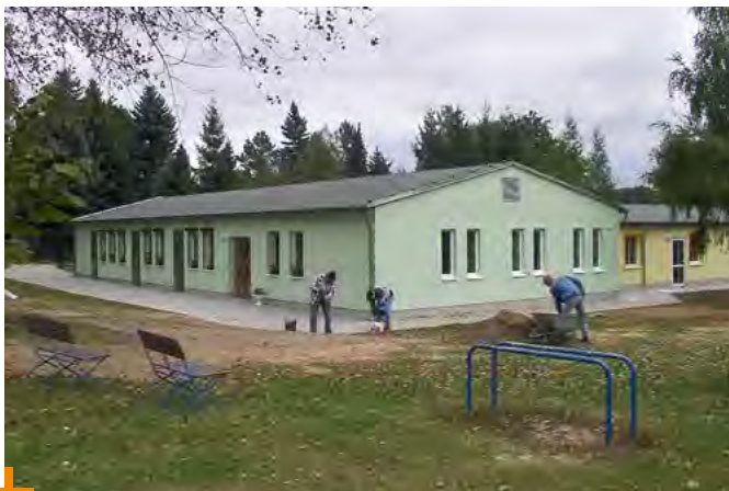
Umbau der Kindertagesstätte »Märchenland«
