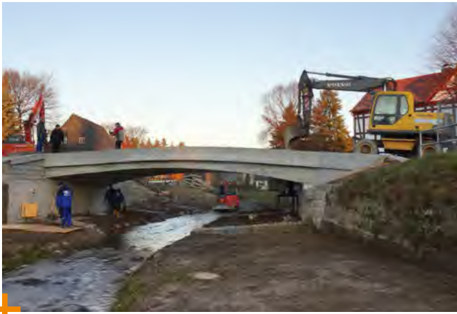
Ersatzneubau der Brücke Gartenstraße
