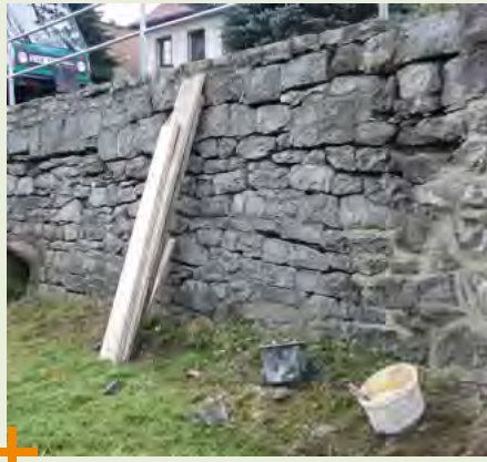
Bachmauerinstandsetzung an der »August-Bebel-Straße«
