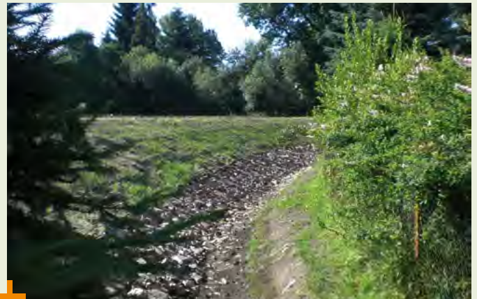
Instandsetzung Graben bei der Freiwilligen Feuerwehr Oberoderwitz
