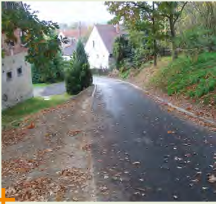
Straßenbaumaßnahme auf dem Seitenweg der »Oberherwigsdorfer Straße«
