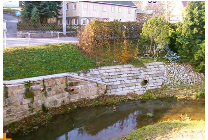
Erneuerung der Stützmauer bei der Brücke »Hutberggasse«
