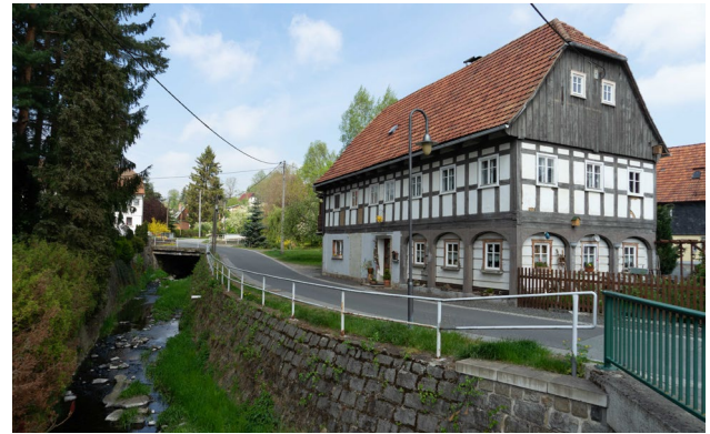
Abb. 27: Landwasser mit gemauerter Uferbefestigung
