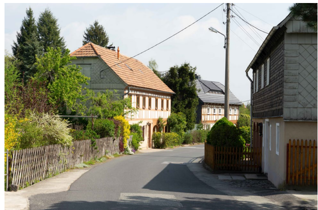
Abb. 21: Umgebindehausensemble in Oberoderwitz
